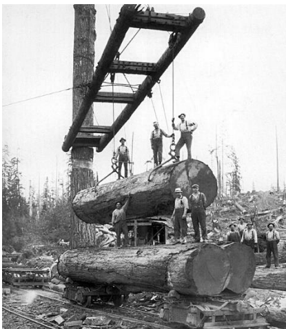
Beladen eines „disconnect log cars“ mit dem „Double tong boom“ am Spar tree (Bild: property of MSCUA University of Washington Libraries)
