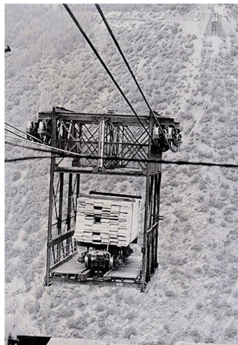
Cableway der Michigan-California Lumber Co. ca 1940 über den American River Canyon (Bild: Sierra Nevada Logging Museum)
