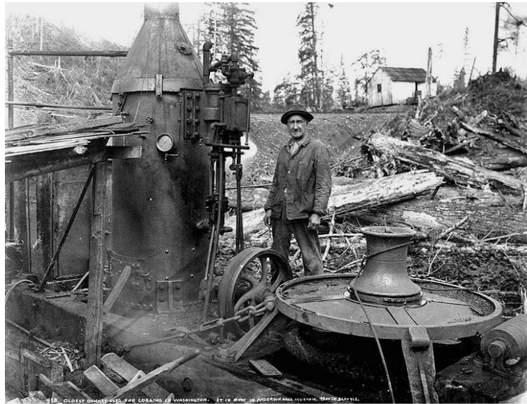
Frühe Dolbeer Winde von 1884. Man beachte die stehende Dampfmaschine neben dem Kessel (Bild: University of Washington Libraries)
